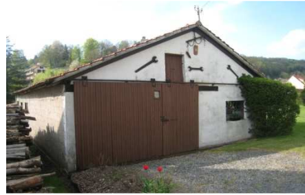
Le bâtiment en face du 20, rue principale ayant servi au forgeron
